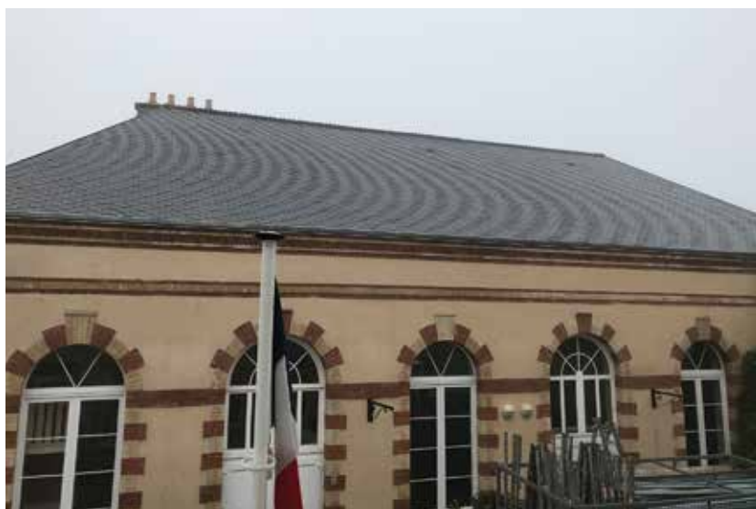
La toiture neuve de la Salle des fêtes
