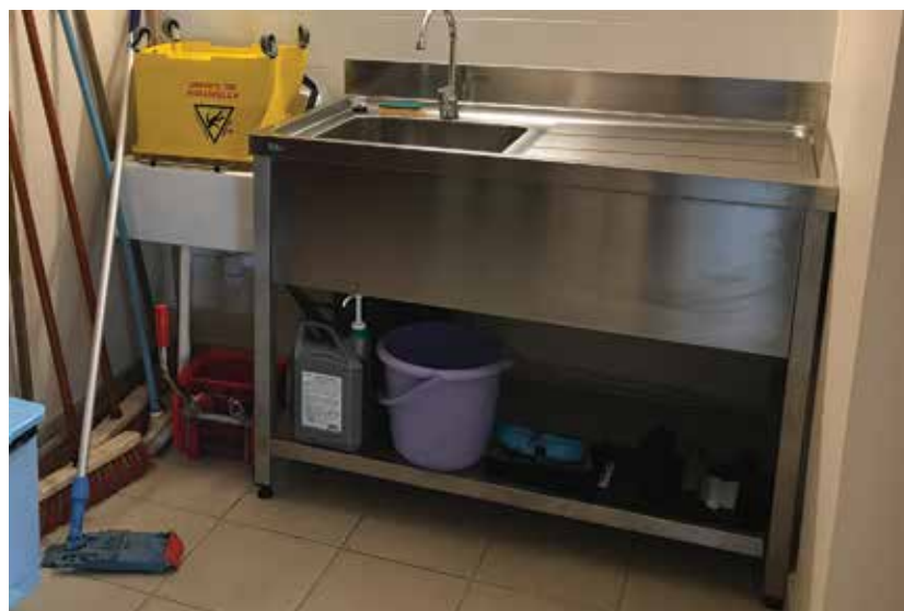
Création d'un point d'eau dans la Salle M-P Fouchet
