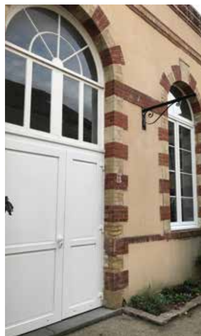
Portes et fenêtres salle des Fêtes
