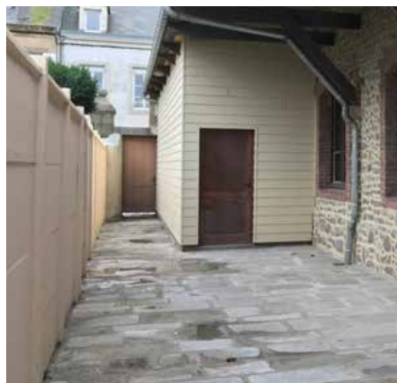
Réhabilitation de la cour
